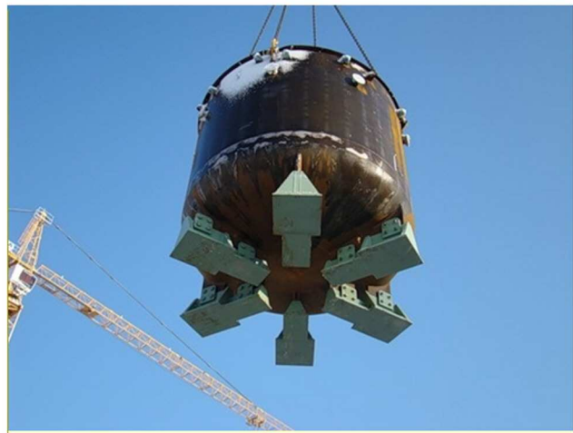
Рис. 1. Фотография корпуса устройства локализации расплава, взятая из [6]
